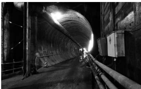
写真2 西公園トンネル現場
