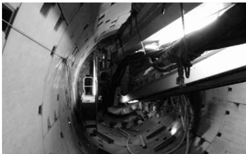
写真1 木ノ下トンネル現場
