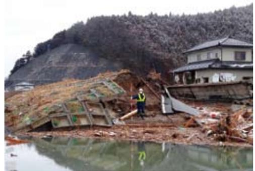
写真-3 津波によって消失した堤防
