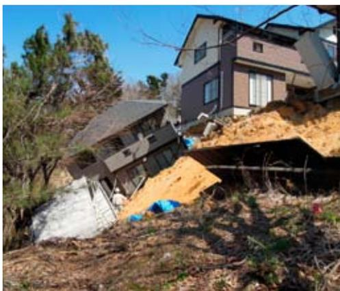
写真-8 地震時の斜面崩壊による住宅被害
