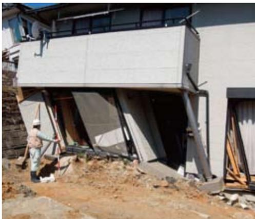
写真-7 地震時の地すべりによる住宅被害
