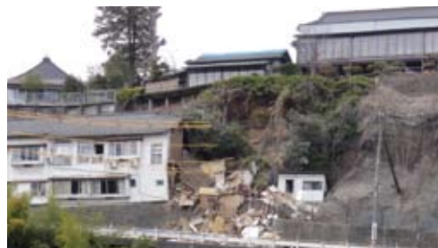
写真1 鹿落坂の斜面崩壊(4月2日撮影)
