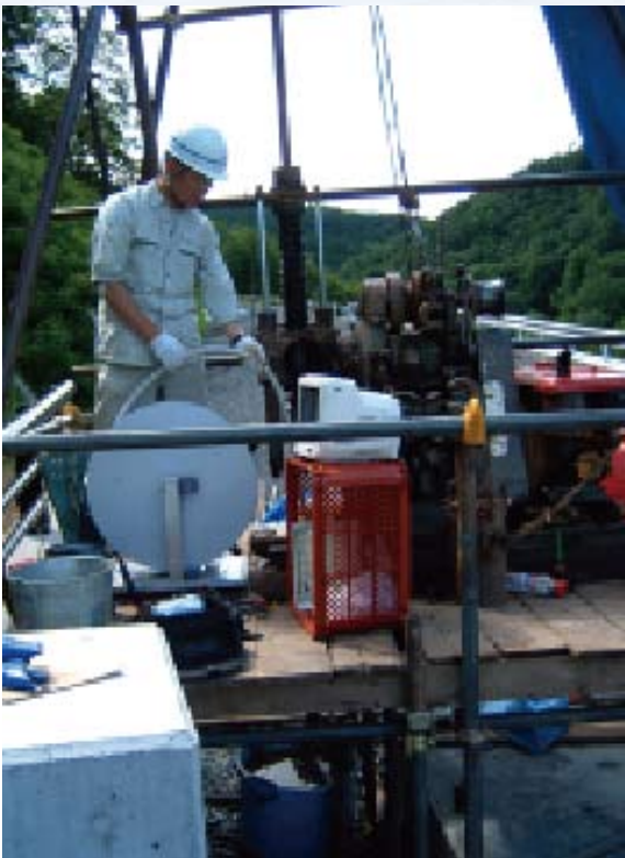
ボアホールカメラ挿入中(ケーブル L=50m)
