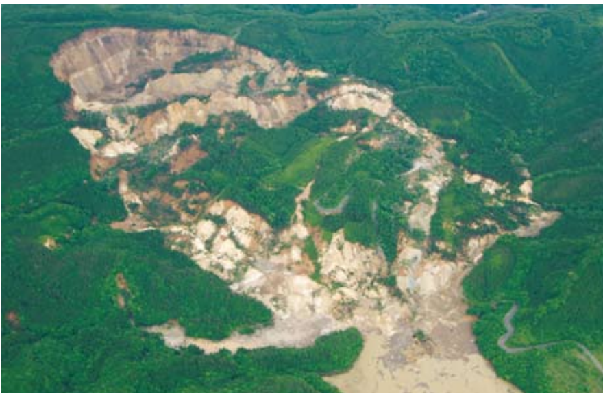
荒砥沢ダム上流の巨大地すべり
