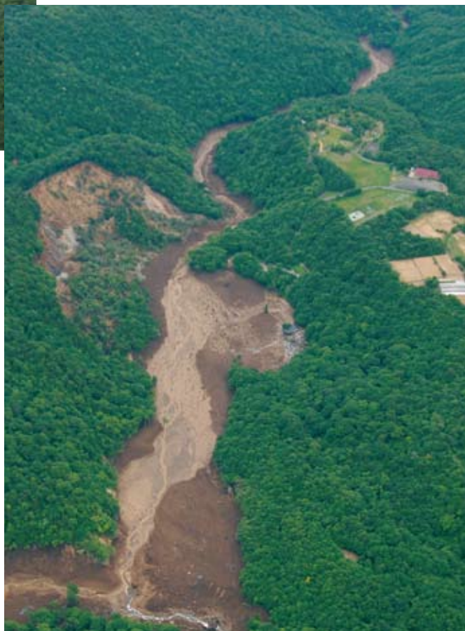
栗駒山ドゾウ沢源流で発生した 土石流が堆積した駒の湯温泉
