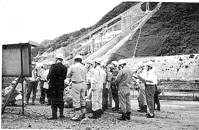
写真1. 研修状況、月山発電所立坑建設現場（月山発電所）
