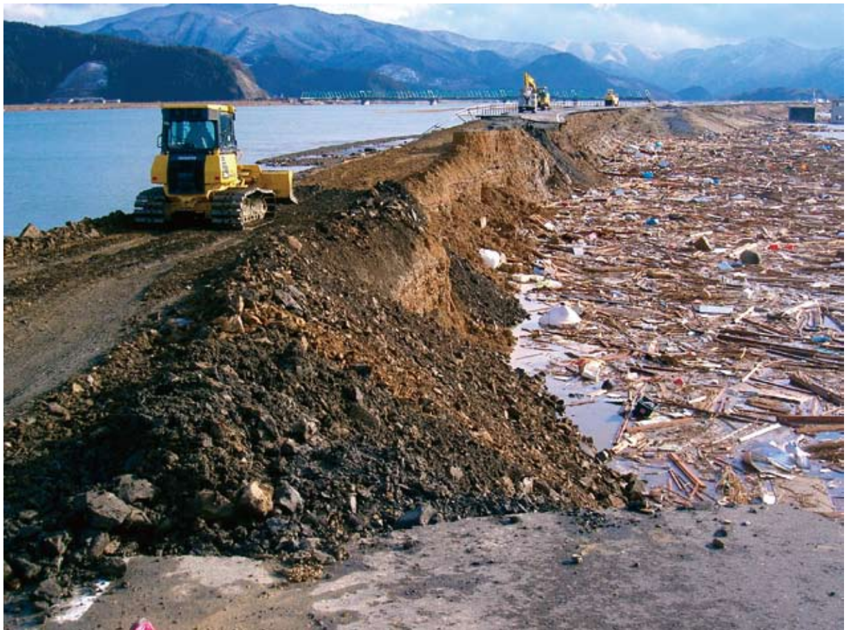
北上川下流の消失した堤防の応急復旧
